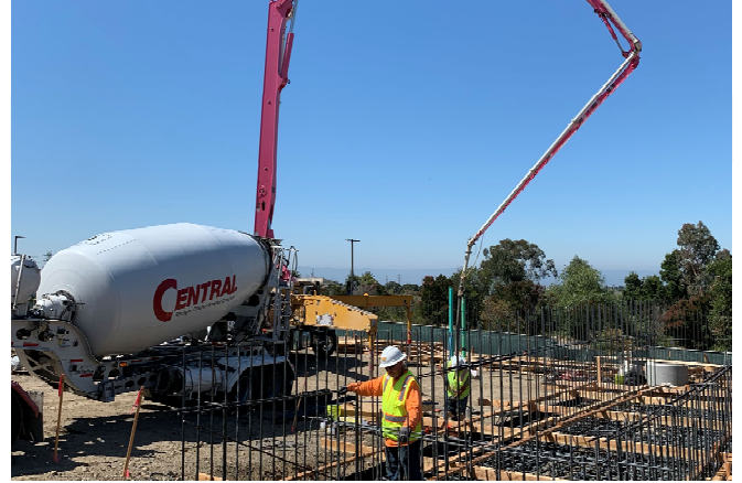
Lot X: Wall footing pour
